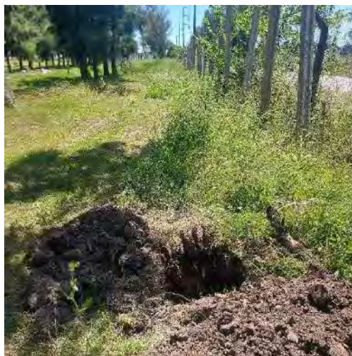
Foto 3.1-1. Excavación en zona de proyecto. Sedimento franco-arcillo-limoso
