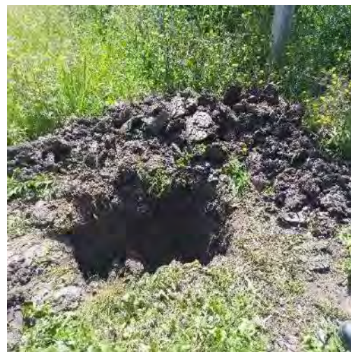
Foto 3.1-2. Excavación en zona de proyecto Sedimento franco-arcillo-limoso.
