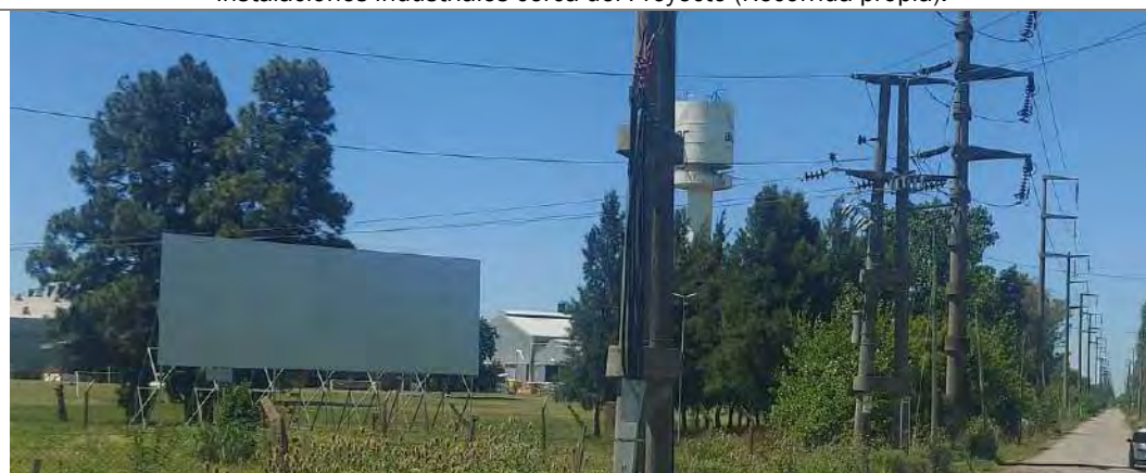
Instalaciones industriales cerca del Proyecto (Recorrida propia).
