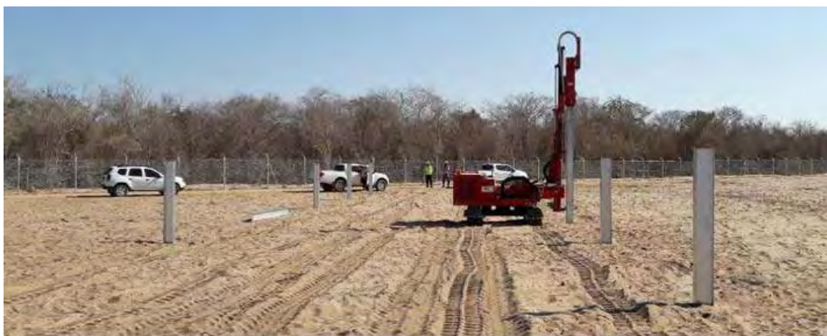
Imagen 2.3-1. Hincado de postes.
