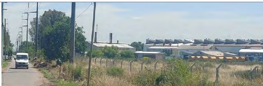
Instalaciones industriales cerca del Proyecto (Recorrida propia).
